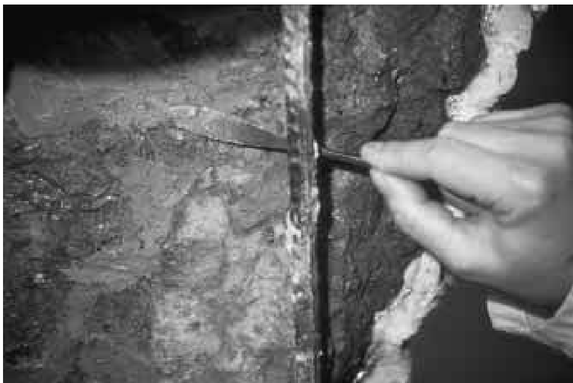
FIG. 201. Aplicación de resina epoxi. Fot. M. Z. J. Garrido.
