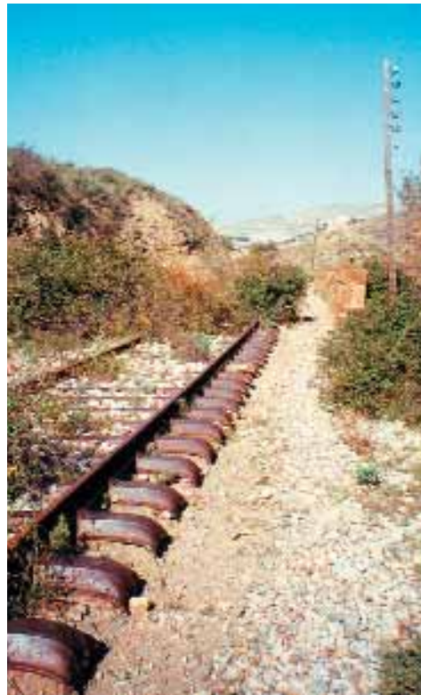
Sobre estas líneas, una vía muerta del antiguo ferrocarril «Central de Aragón» a su paso por Villafeliche. Arriba, antiguo molino de piedra en el que se trituraba la mezcla de salitre, azufre y carbón.
