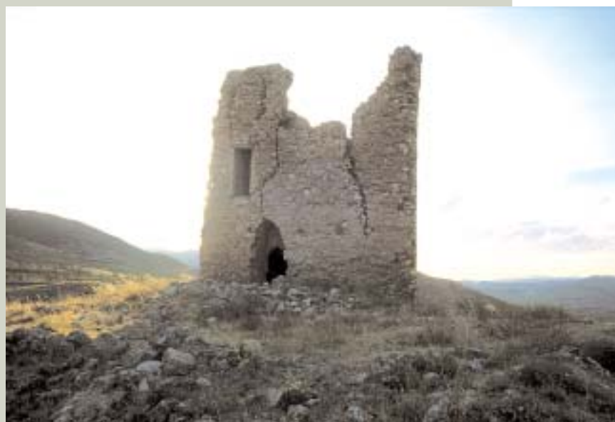
El Torreón de Las Encantadas.
